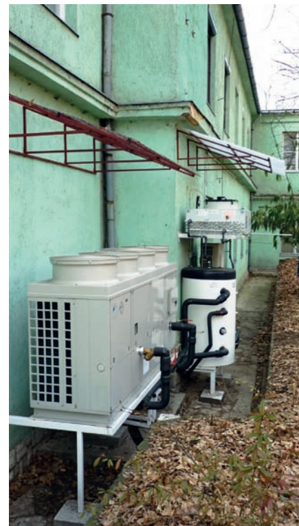
■ Az épület külső falára szerelt vízhűtő rendszer
